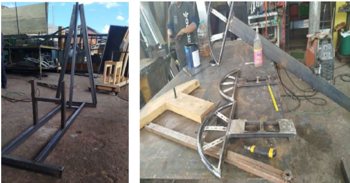
Figura 2. Montaje del balancín
