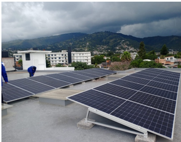
Figura 1. Instalación de Paneles Solares.
